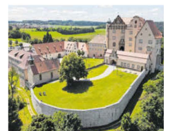
Schloss Kapfenburg liegt oberhalb von Lauchheim. Foto: Matthias Schmidt
